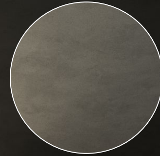
REVESTIMIENTO Pintura texturizada
